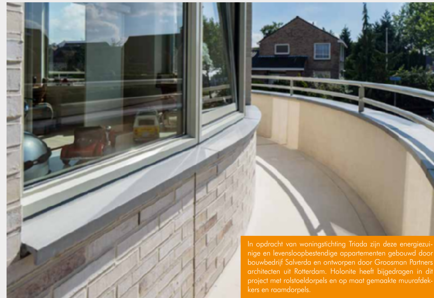
Project 3: Nieuwbouw 60 appartementen Uilennest te Hattem Op maat gemaakte muurafdekkers en raamdorpels
